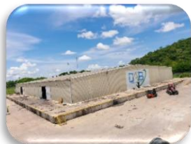
RECINTO ADUANA DE FRONTERA PUERTO SUAREZ
